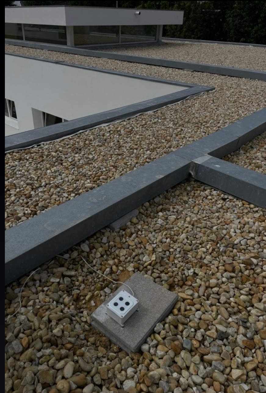
Exemplo de fotómetro já instalado (Caminha)
